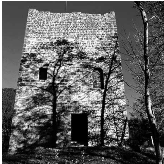
La Torre Moscarda restaurata.
