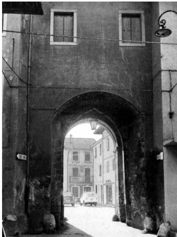
Tolmezzo, Porta di Sotto vista dall'interno della città.
