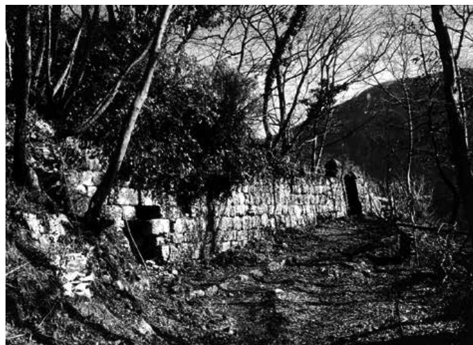
Tratto del recinto murato di Cort dal Salvan.
