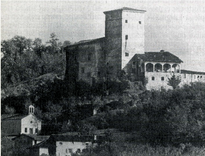
Il castello di Prampero prima del terremoto.
