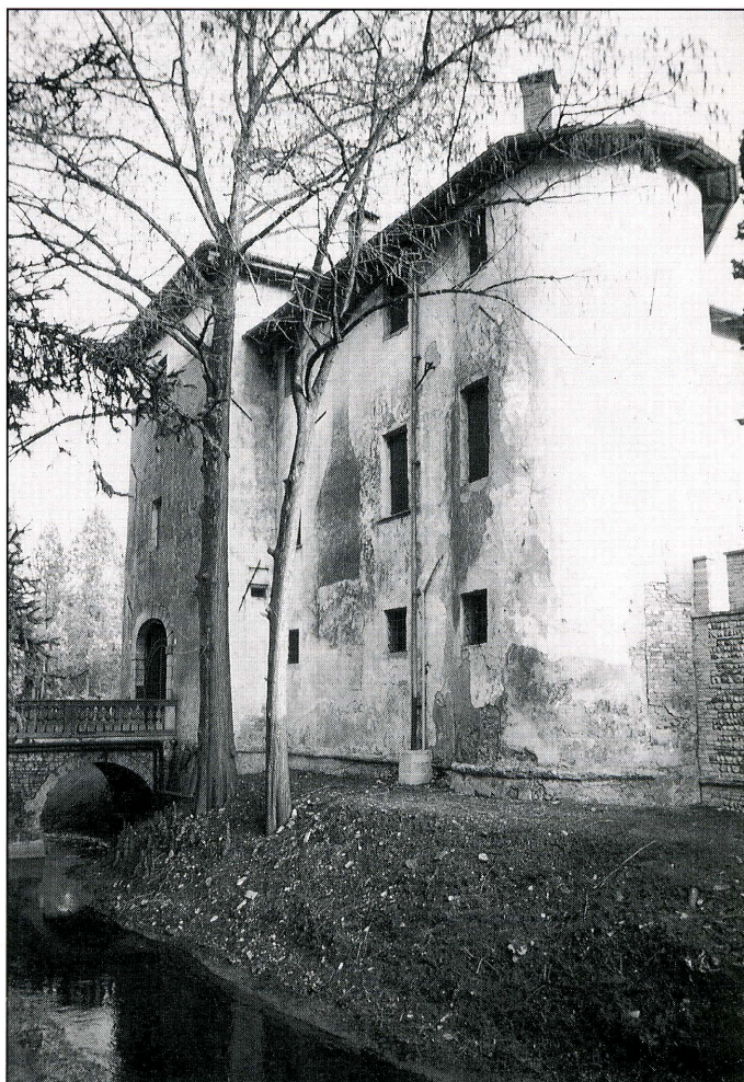
Flambruzzo - torre portaia e torre circolare
