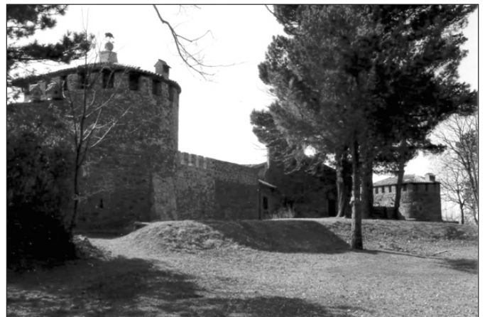
Castello di San Floriano del Collio (GO) particolare della Torre della Bora e di parte delle mura di cinta verso nord
