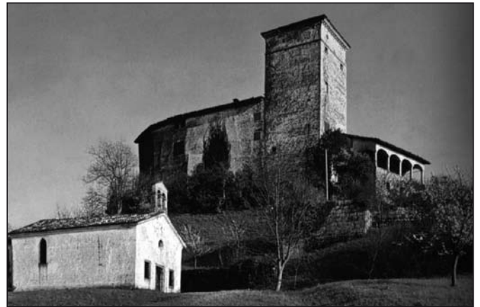
Castello di Prampero prima del sisma del 1976
