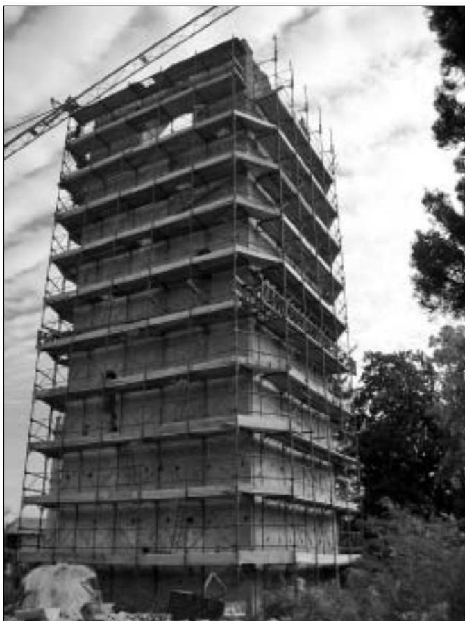
Torre di Sbrojavacca
